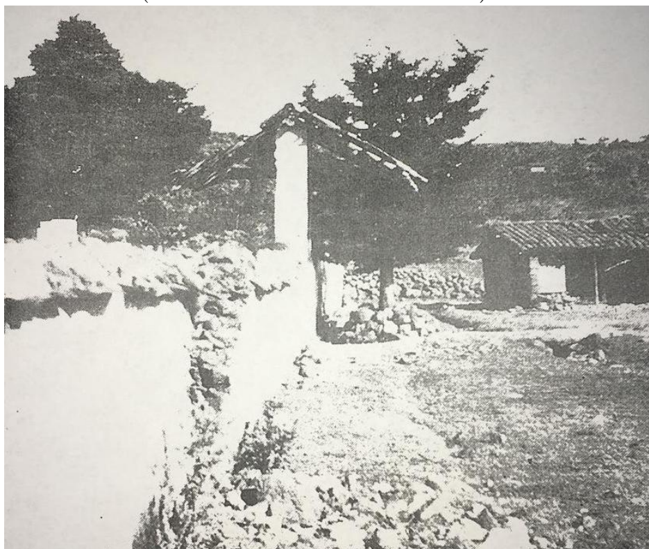
A consecuencia del temblor de 1912 se derrumbó la barda del atrio del templo (San Lorenzo Tlacotepec. Monografía. 2016)
